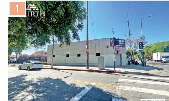
6200 S Western Ave Los Angeles, CA 90047
